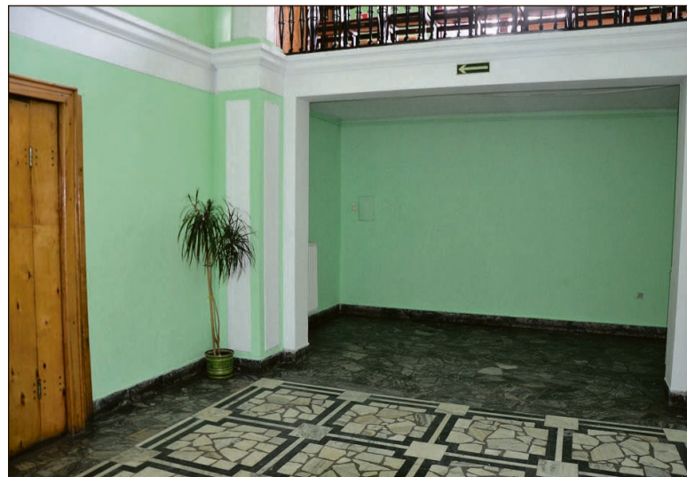
...i miejsce, w którym powstanie nowa
