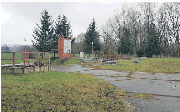
Pompownia Z-3 przy ul. Legnickiej, przy której zamontowane zostaną panele fotowoltaiczne
